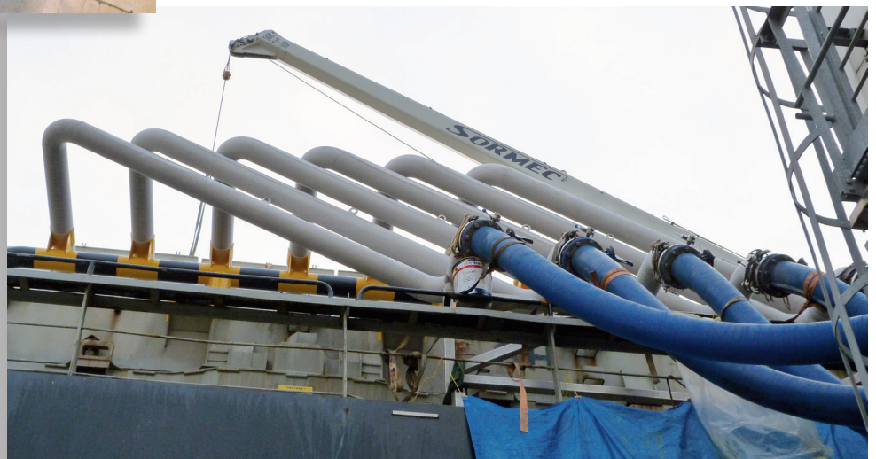
De aansluiting van het schip op de terminal
